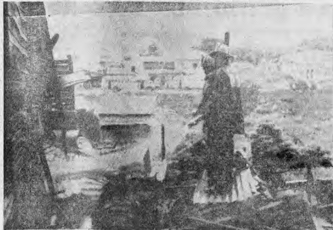
INCENDIO DESTRUYO PROPIEDADES — Aspecto parcial de los escombros en que quedaron convertidas tres propiedades de Barrio Luna Park, con motivo del voraz incendio desatado en las primeras horas de la tarde de ayer. Los restos lamentosos de las casas reciben los últimos chorros de agua por parte de los bomberos.
